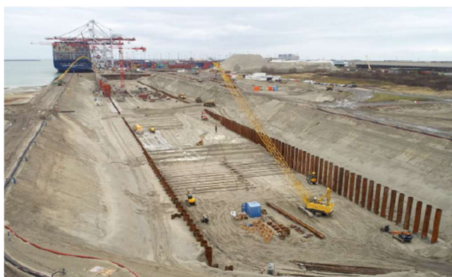
FIGURE 17 : ILLUSTRATION DE LA MISE EN PLACE DE TIRANTS (source : Grand Port Maritime de Dunkerque)
