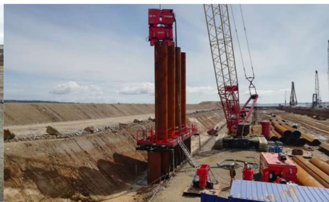
FIGURE 18 : ILLUSTRATION DE L'INSTALLATION D'UN RIDEAU MIXTE DE TYPE COMBIWALL, PIEUX-PALPLANCHES (source : EGIS)
